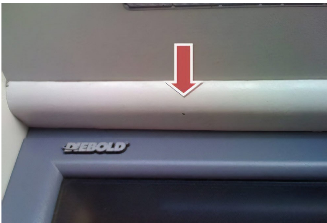
Камера в фальш-панели под козырьком банкомата:
